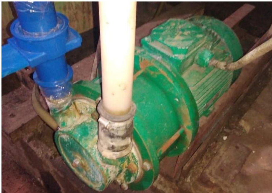
Установка вакуумная водокольцевая УВВ-Ф-60
